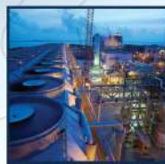
液化天然气 再气化站
